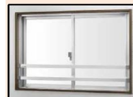
転落防止の手すりの設置
